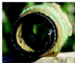
Canalisation en PVC (D = 110 mm)
